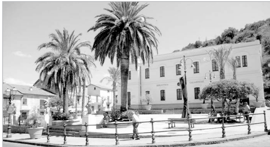
“GIOIELLO” La biblioteca calabrese di Soriano Calabro che affaccia sulla piazza centrale
